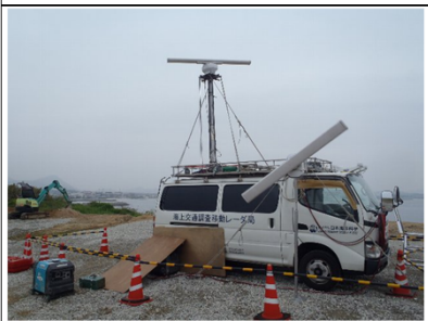
定点調査（レーダー探査）
